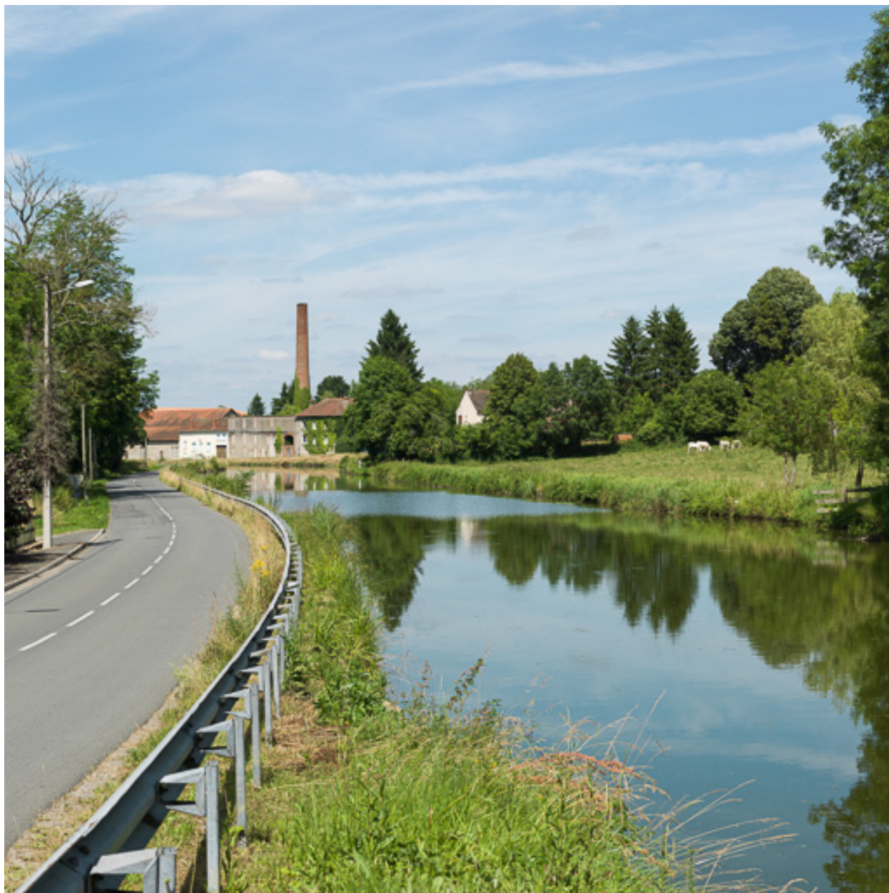
Vue d'ensemble d'aval.
