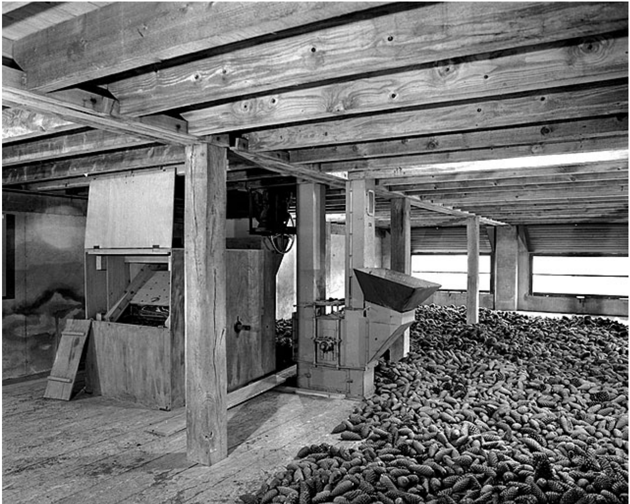
Etage en surcroît d'une pièce de séchage. De gauche à droite : batteur, élévateur à godets et aire de séchage des cônes de résineux.
