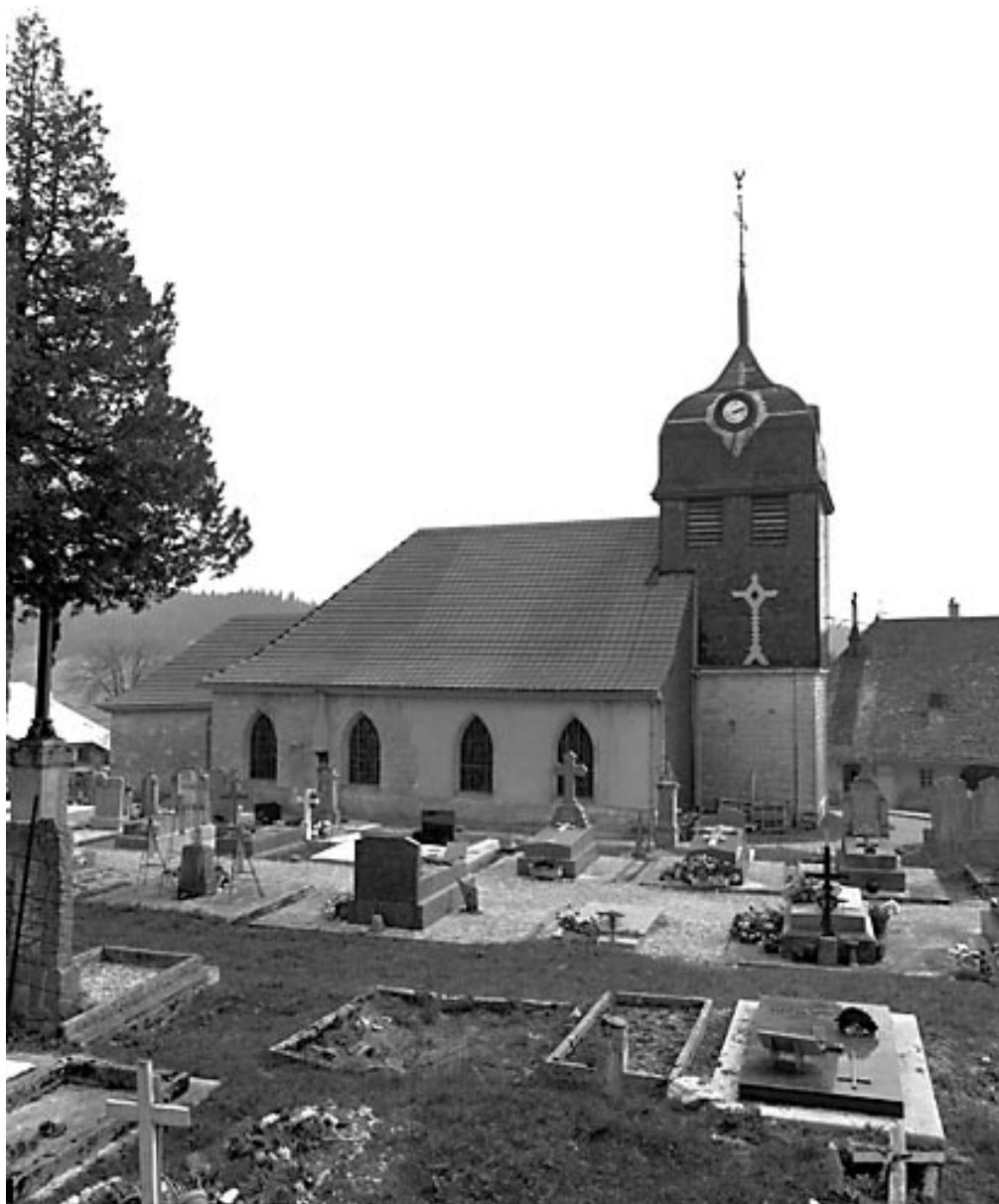
Vue de la façade latérale nord.
