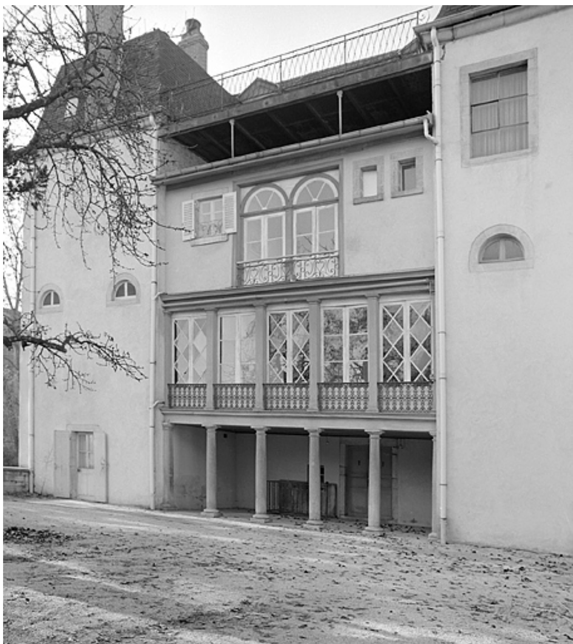
Façade postérieure, détail.
