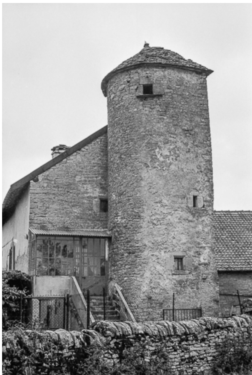
Ferme : tour et mur en pierre sèche.
