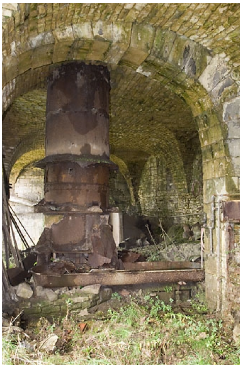
Cubilot ouest, dans son environnement.
