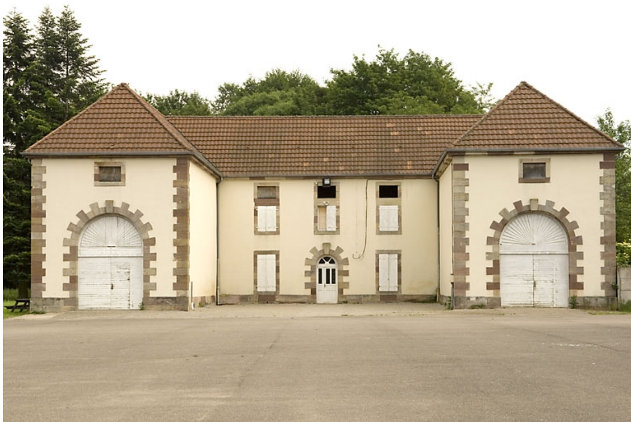
Ecuries et remises. Vue de face.
