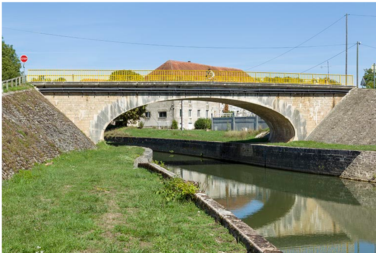
Pont de la dérivation de Soing (70).
