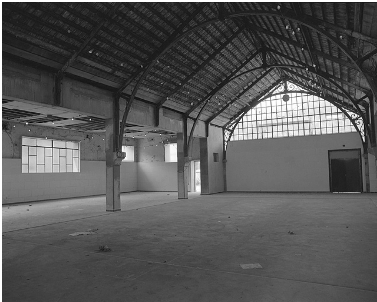
Vue intérieure de la halle.
