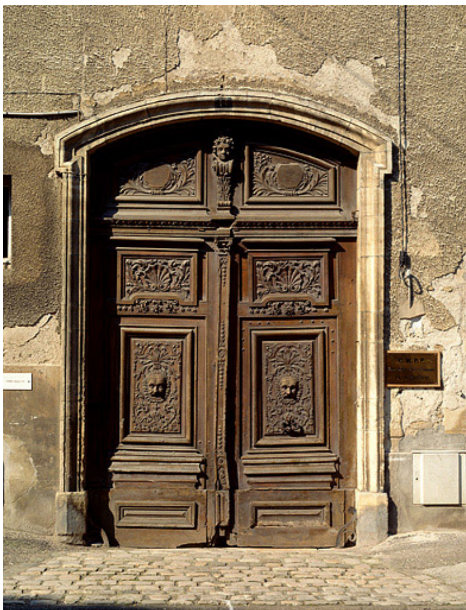
Détail de la porte d'entrée.
