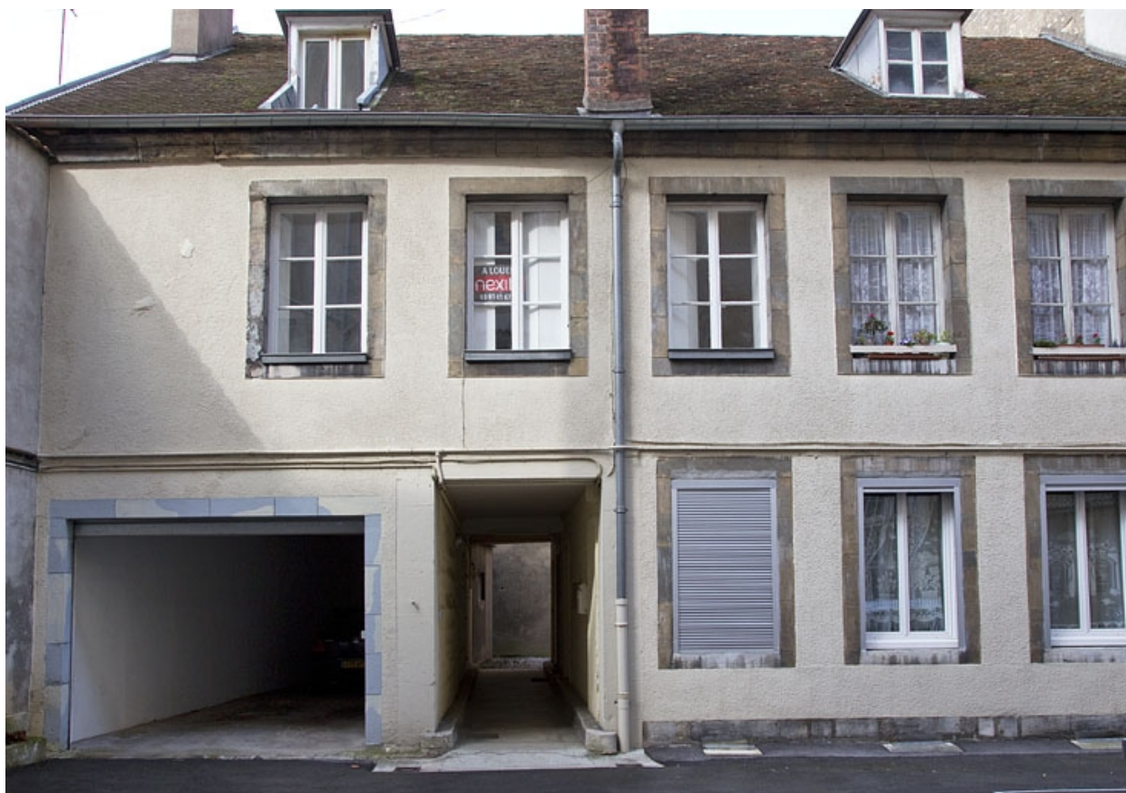
Logis secondaire, façade antérieure, de face.
