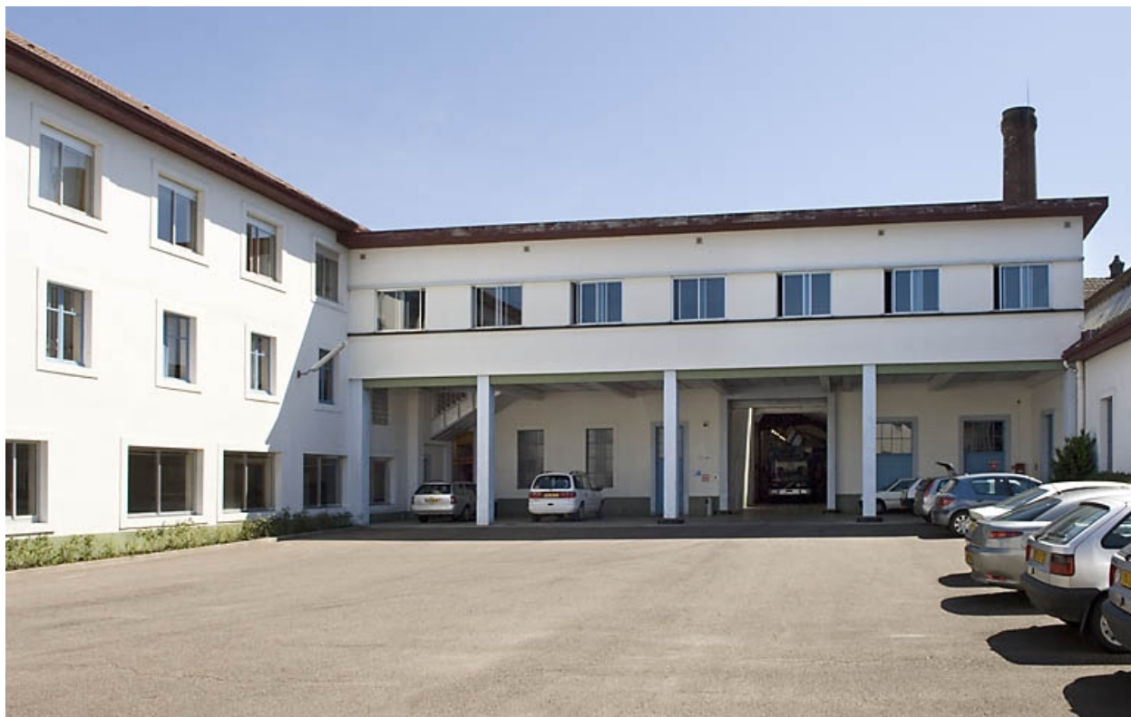
Cour de l'usine. Vue depuis l'ouest.
