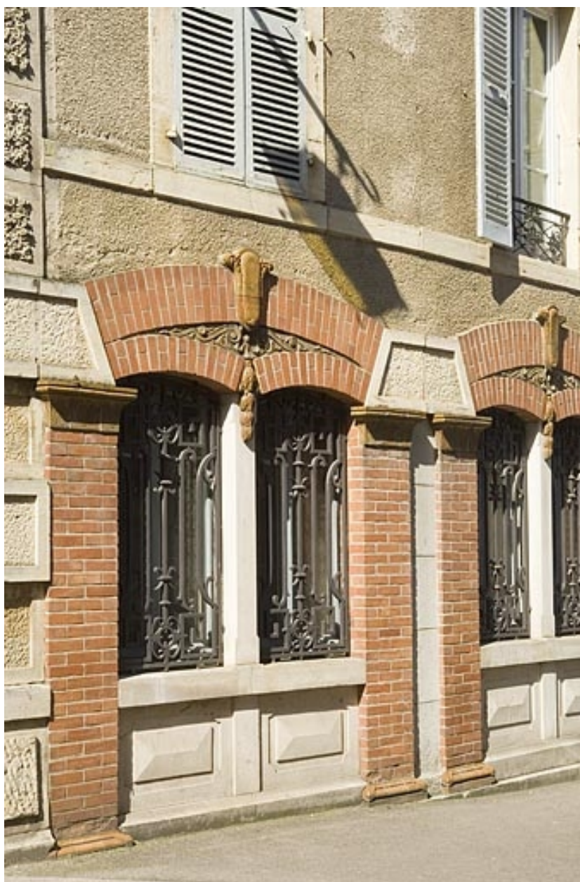
Travée à fenêtre double
