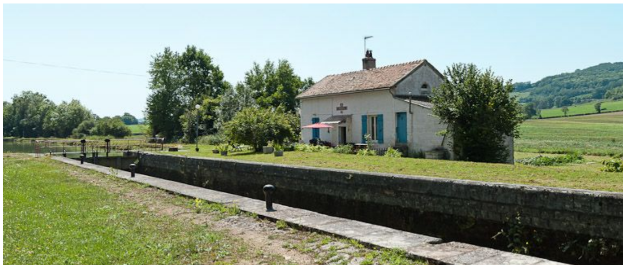
Vue d'ensemble du site d'écluse.
