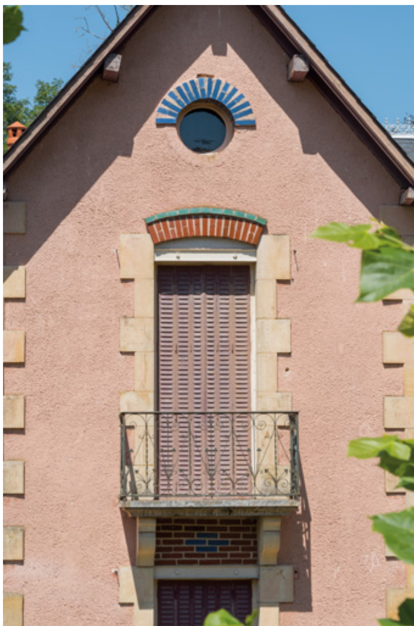
Mur-pignon, détail des ouvertures, vue de face.
