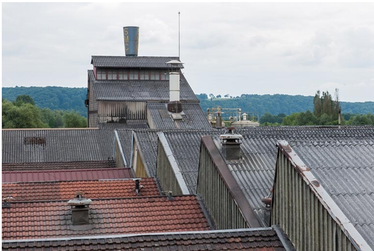
Toitures de l'usine.
