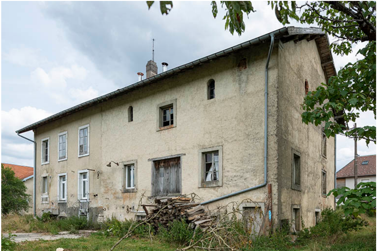
Façades postérieure et latérale gauche.
