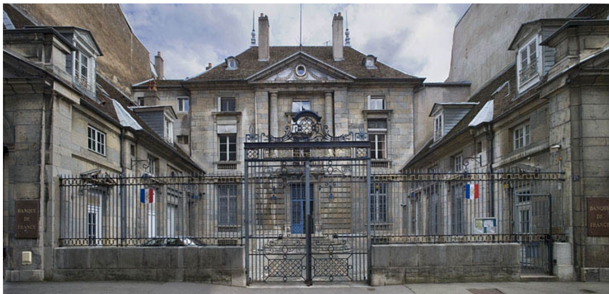
Vue d'ensemble de face depuis la rue.
