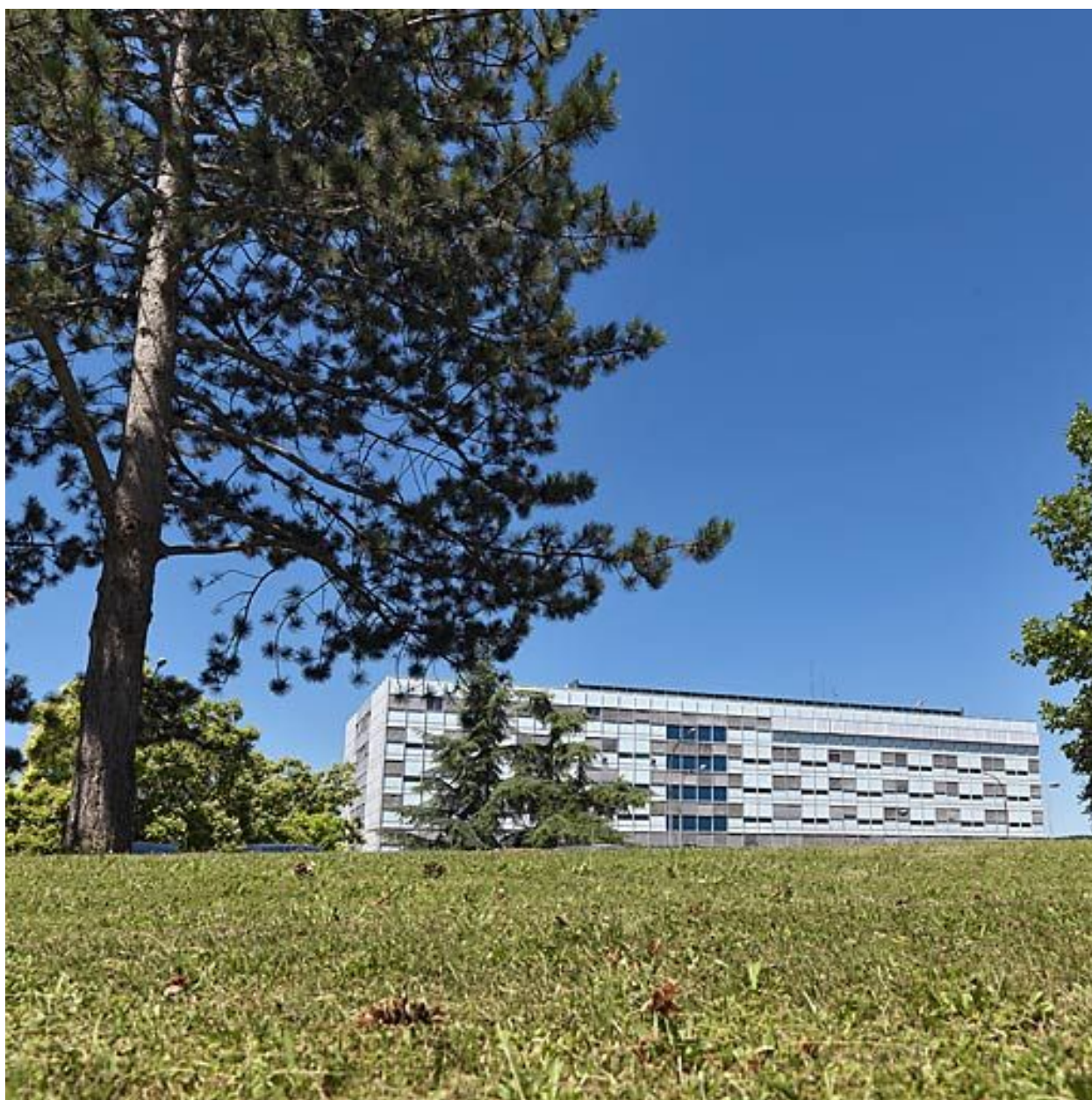
Bâtiment principal, vue d'ensemble.
