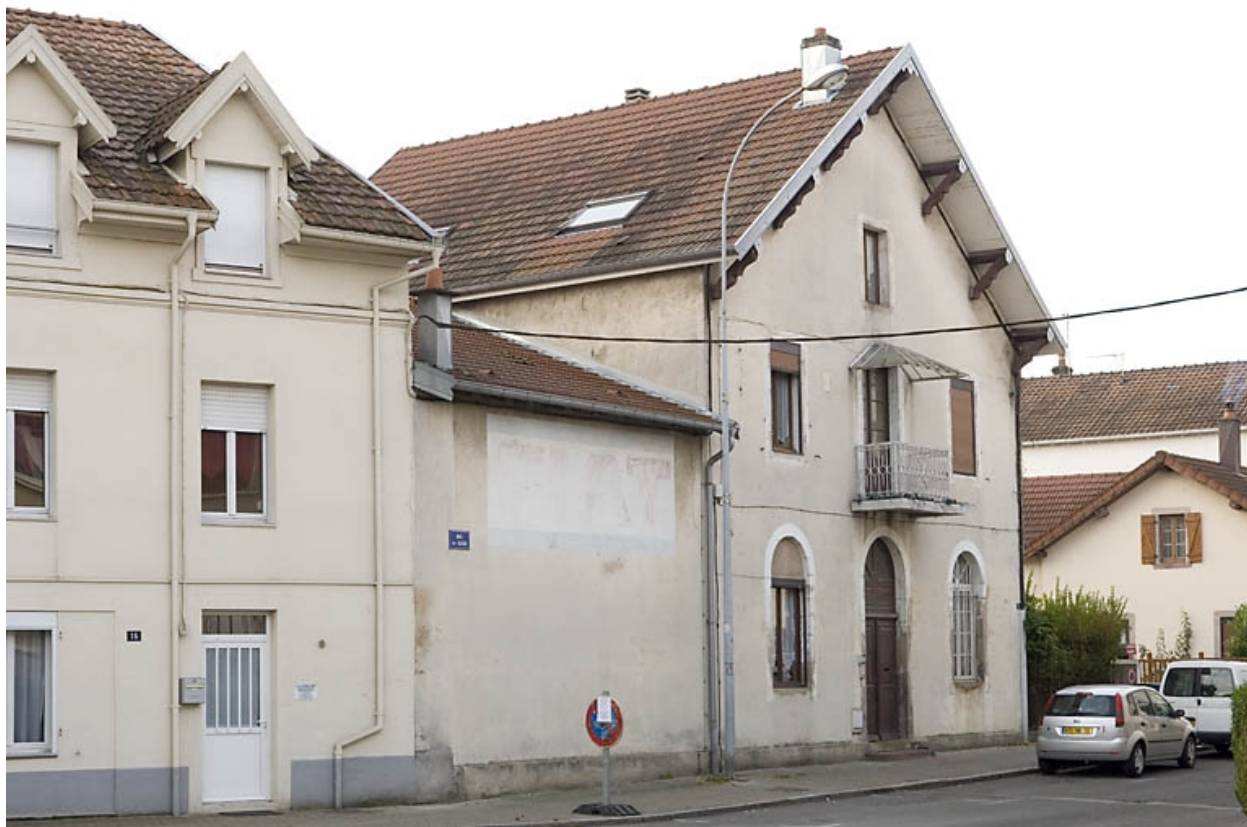
Logement patronal. Vue de trois quarts.
