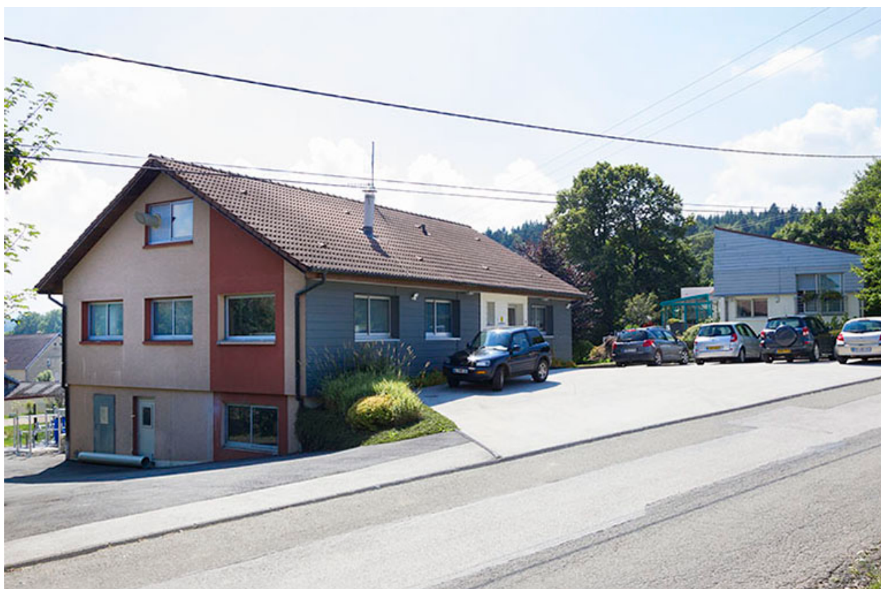
Usine : façade antérieure.
