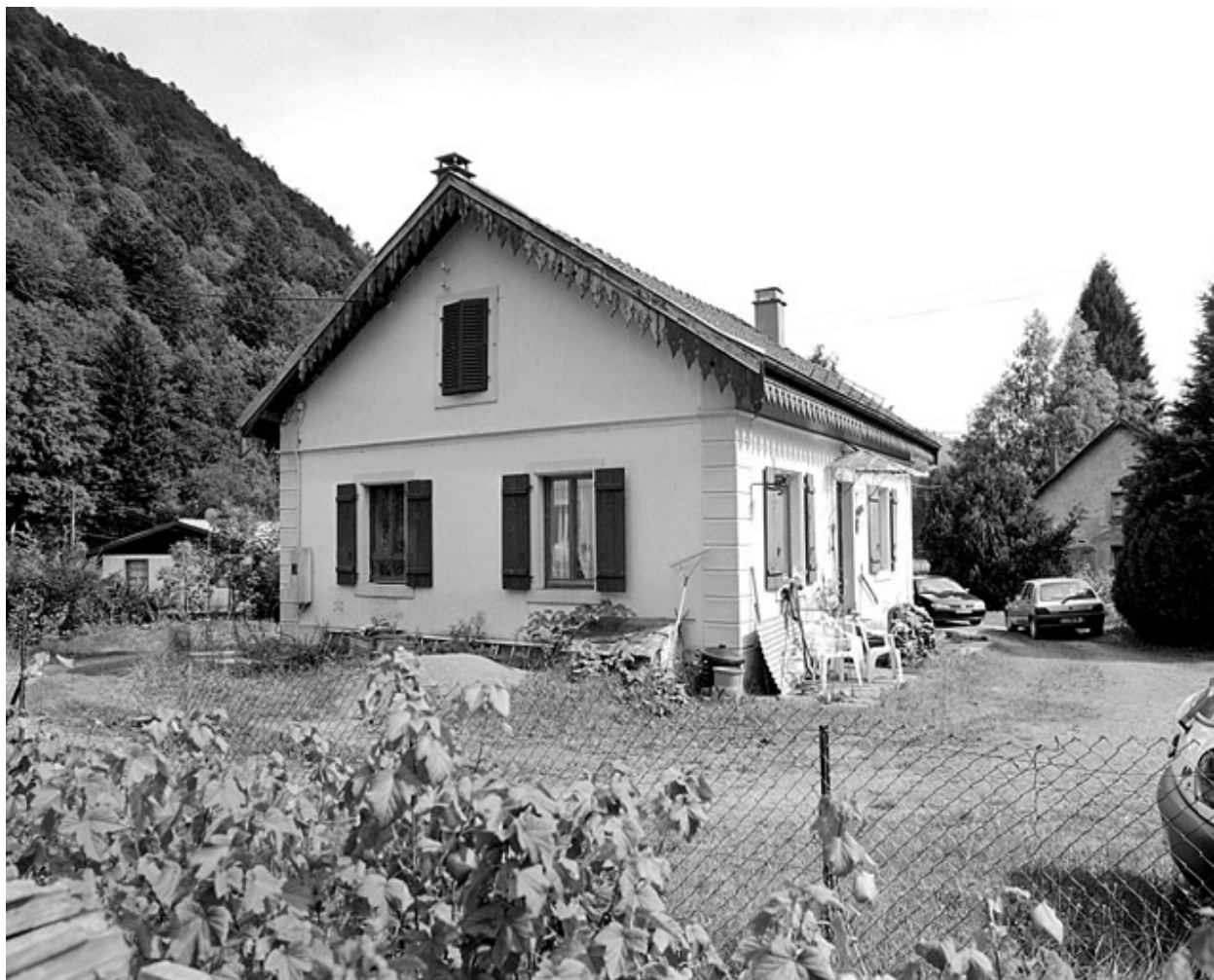
Logement de contremaître.
