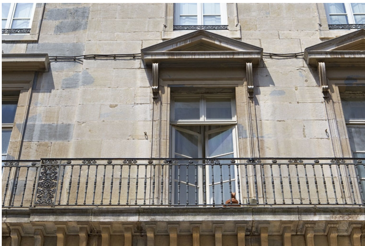
Façade antérieure : détail du balcon.
