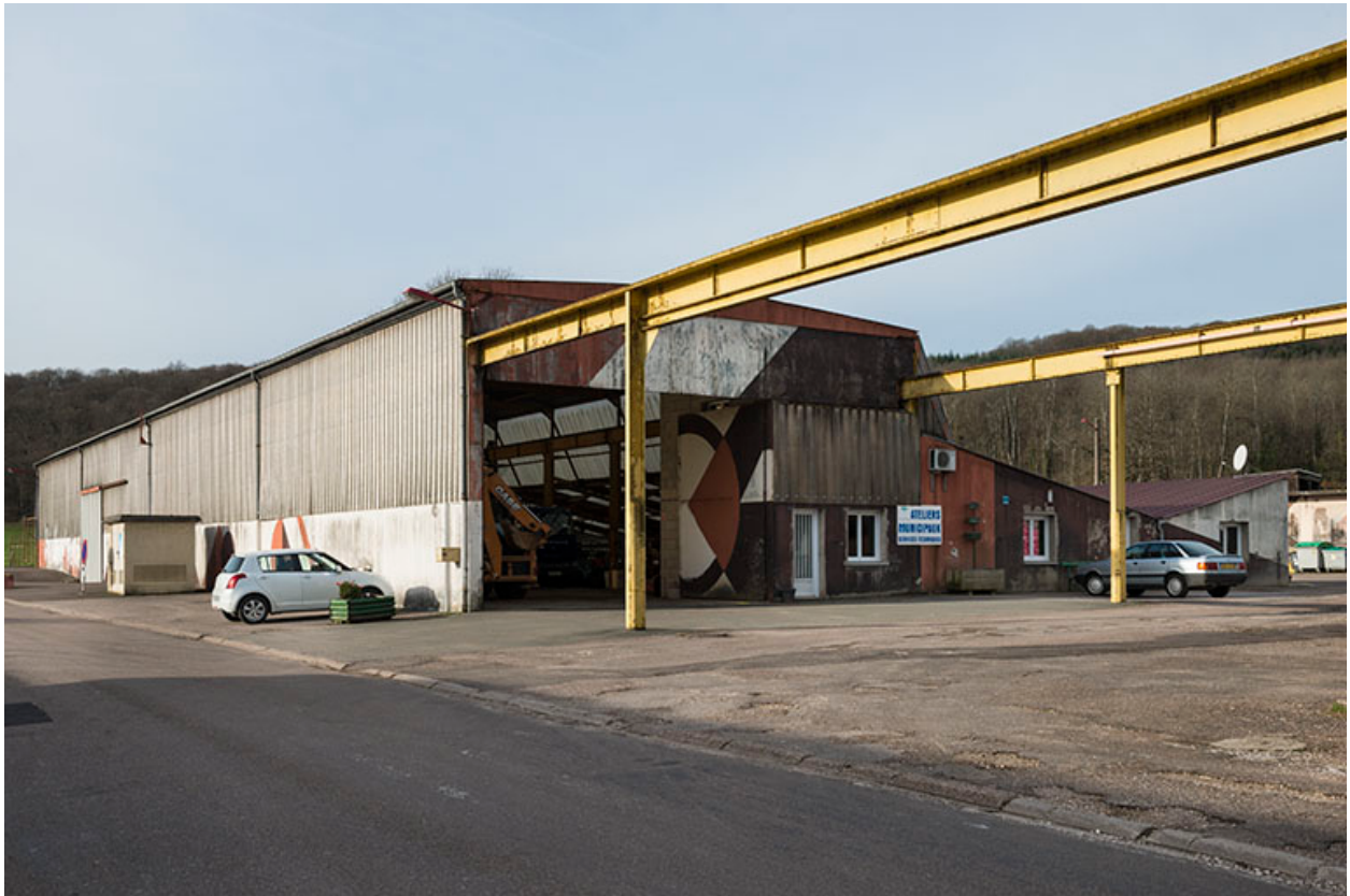
Le bâtiment d'entretien des véhicules.
