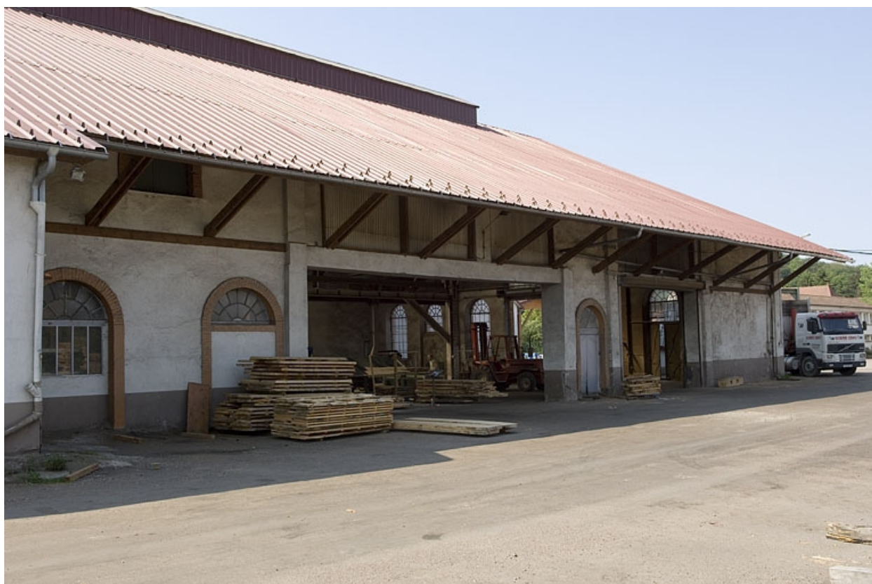
Façade nord de l'atelier de fabrication.
