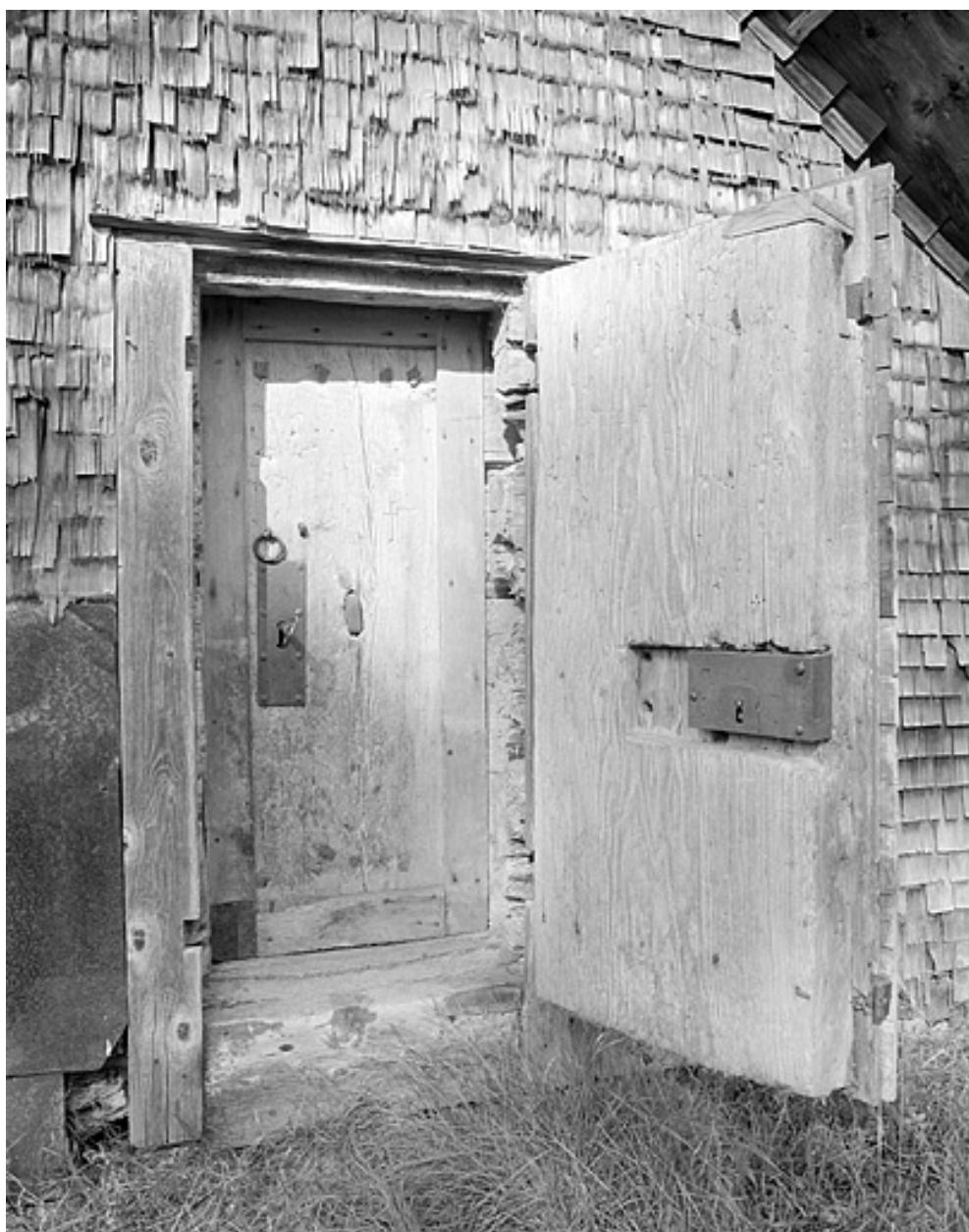
Double porte d'accès du grenier fort.
