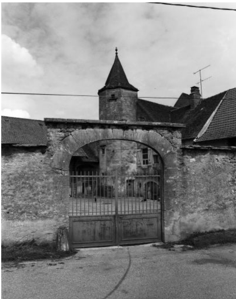
Vue du portail depuis la rue.
