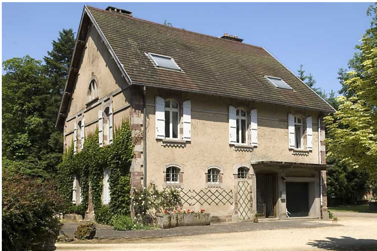
Logement (ancien chenil). Vue de trois quarts.
