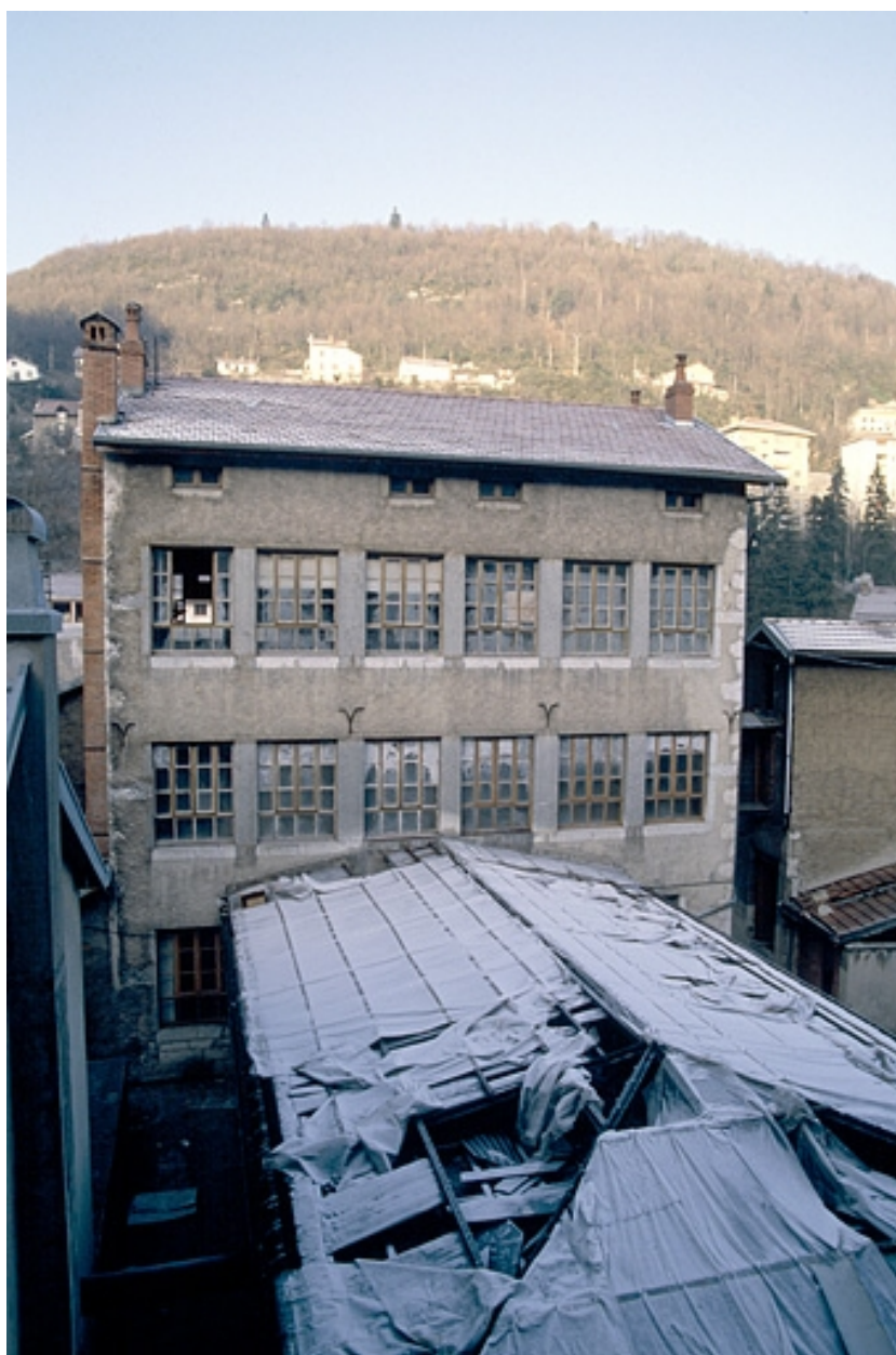
Atelier de fabrication : façade antérieure.
