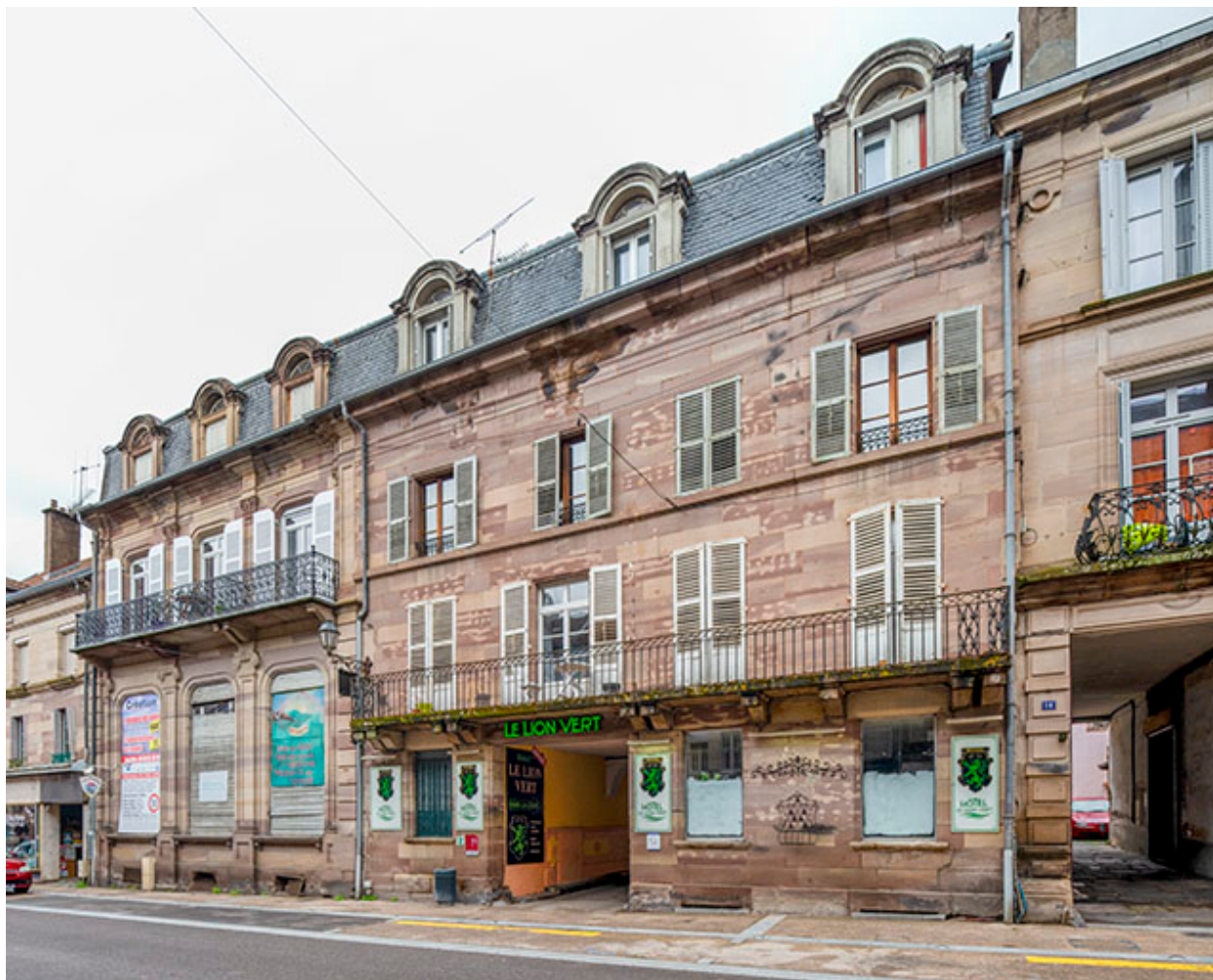
Vue d'ensemble depuis la rue.
