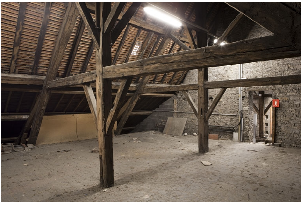
Intérieur, comble : détail de la charpente.
