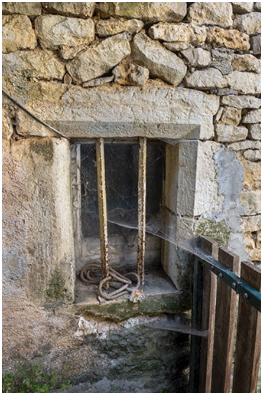
Baie chanfreinée au rez-de-chaussée.
