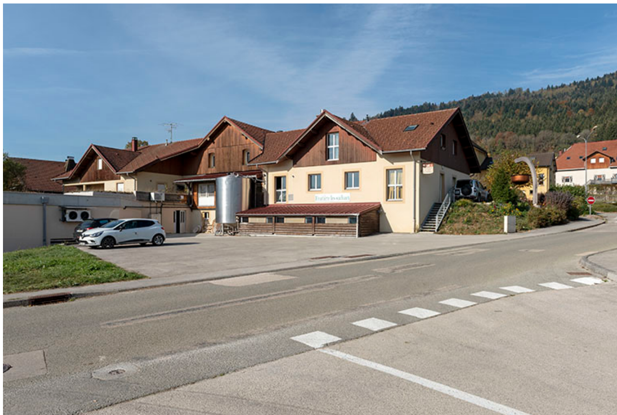
Façades postérieure et latérale gauche.
