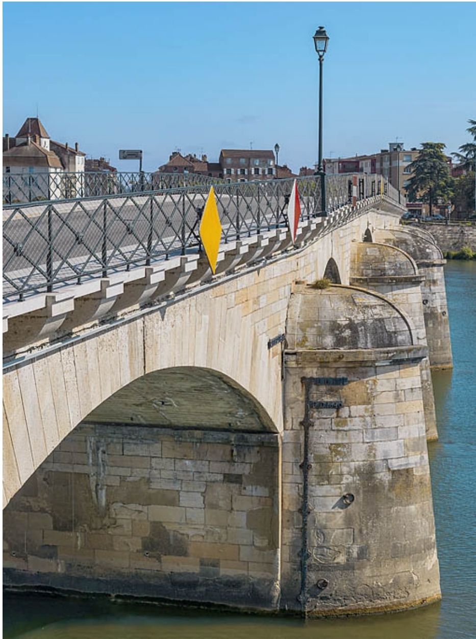
Détail des arrière-becs du pont.
