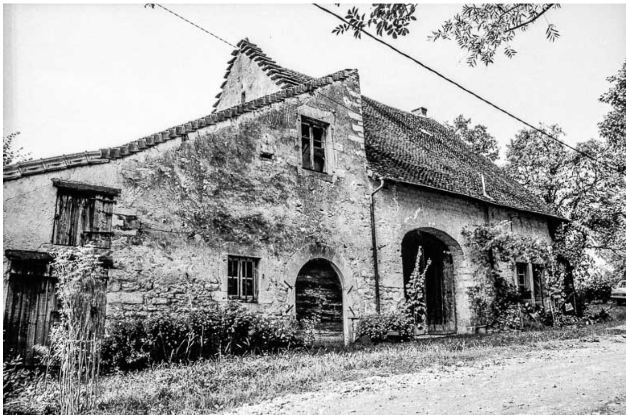
Ferme cadastrée 1964 AC 48 : vue d'ensemble.
