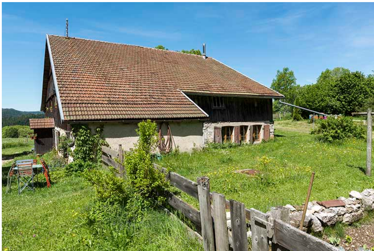
Façade latérale droite.
