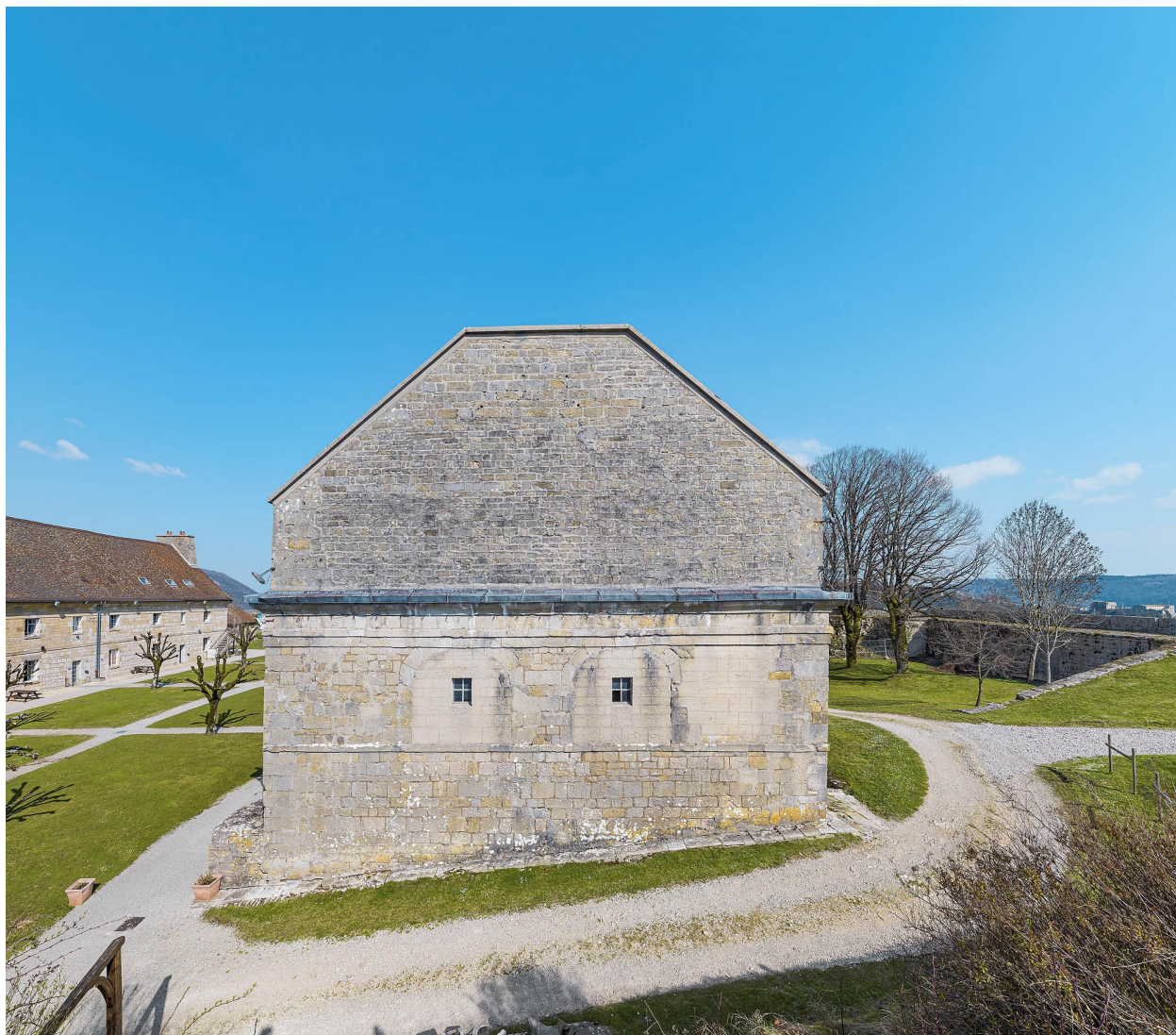
Caserne V : Mur pignon.
