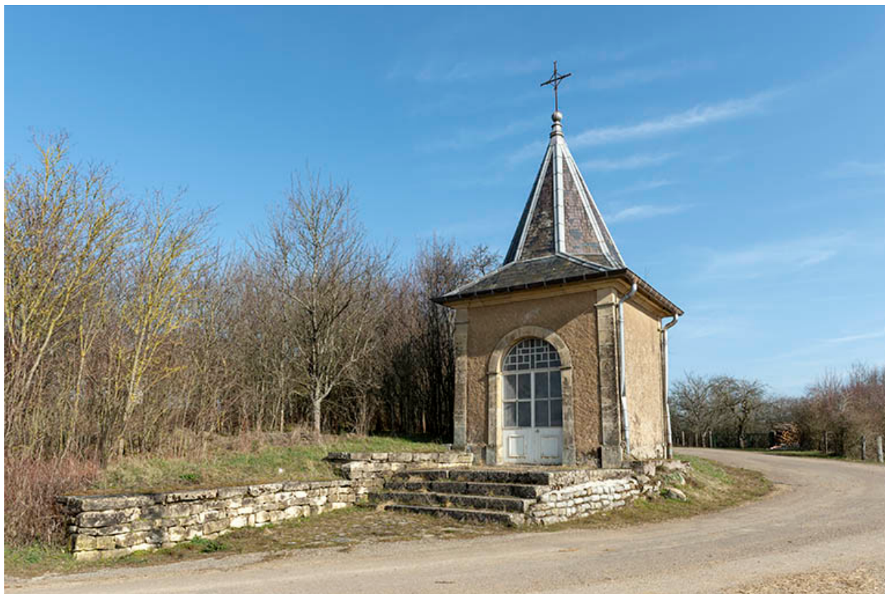
Vue de trois quart depuis l'ouest.
