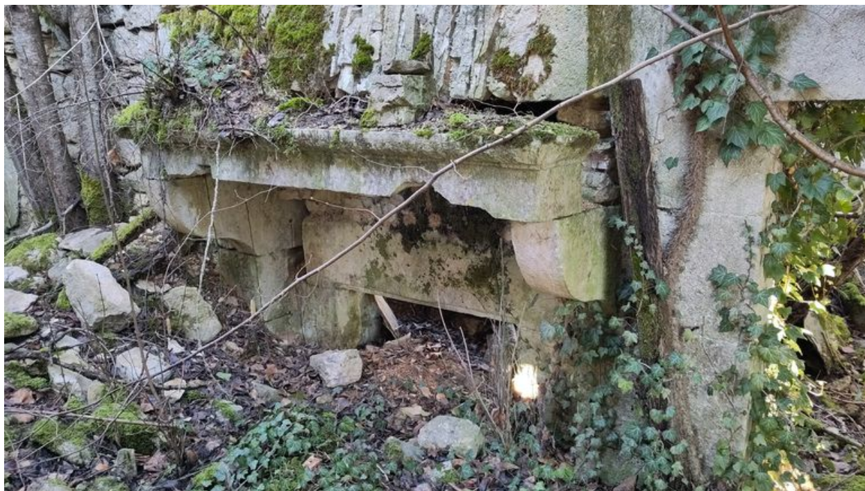
Détail d'une cheminée conservée à l'intérieur du moulin.
