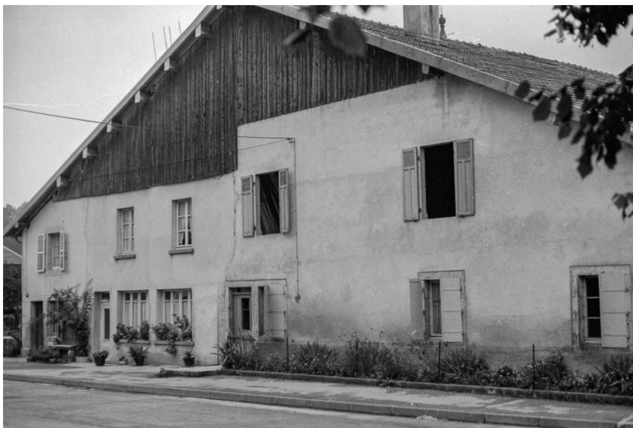
Ferme cadastrée 1939 F 183-184 : façade antérieure.
