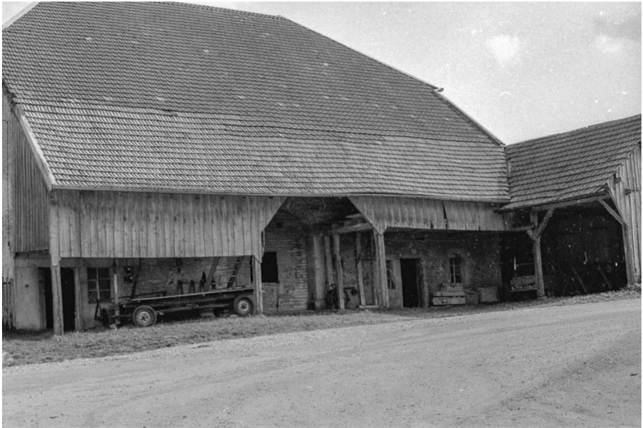
Ferme cadastrée 1945 d 154-155 : façade postérieure.
