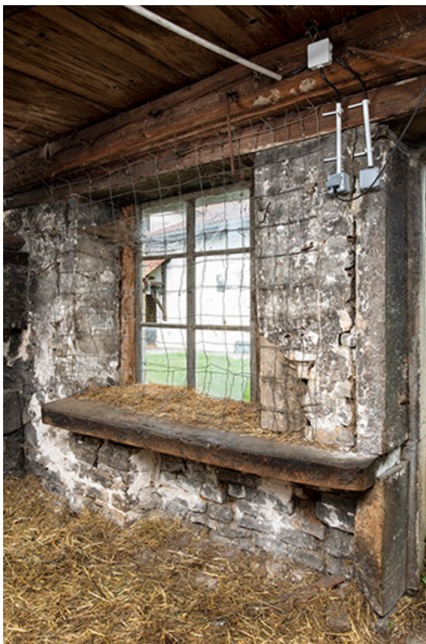
Forge nord : fenêtre et établi.
