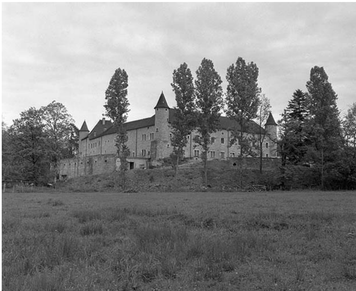
Façades nord et ouest.
