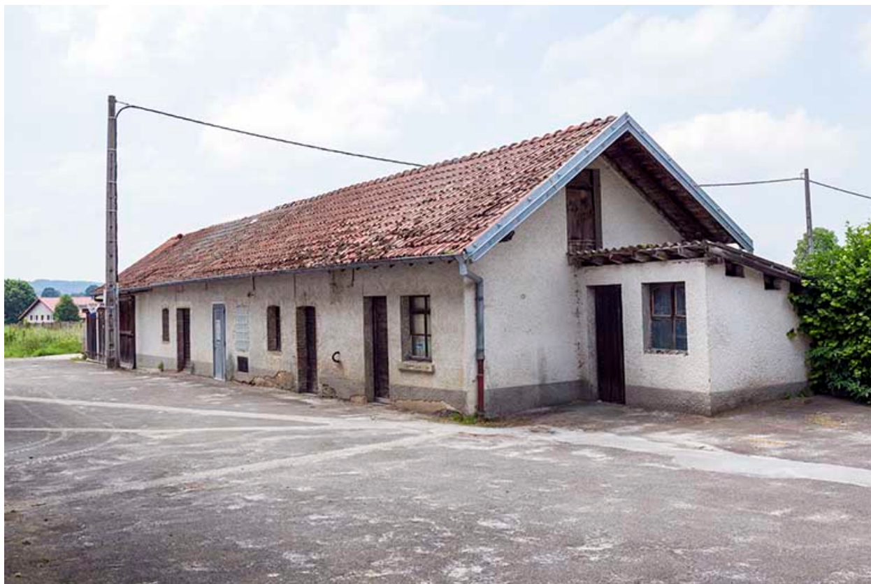
Etable, transformateur et garage.
