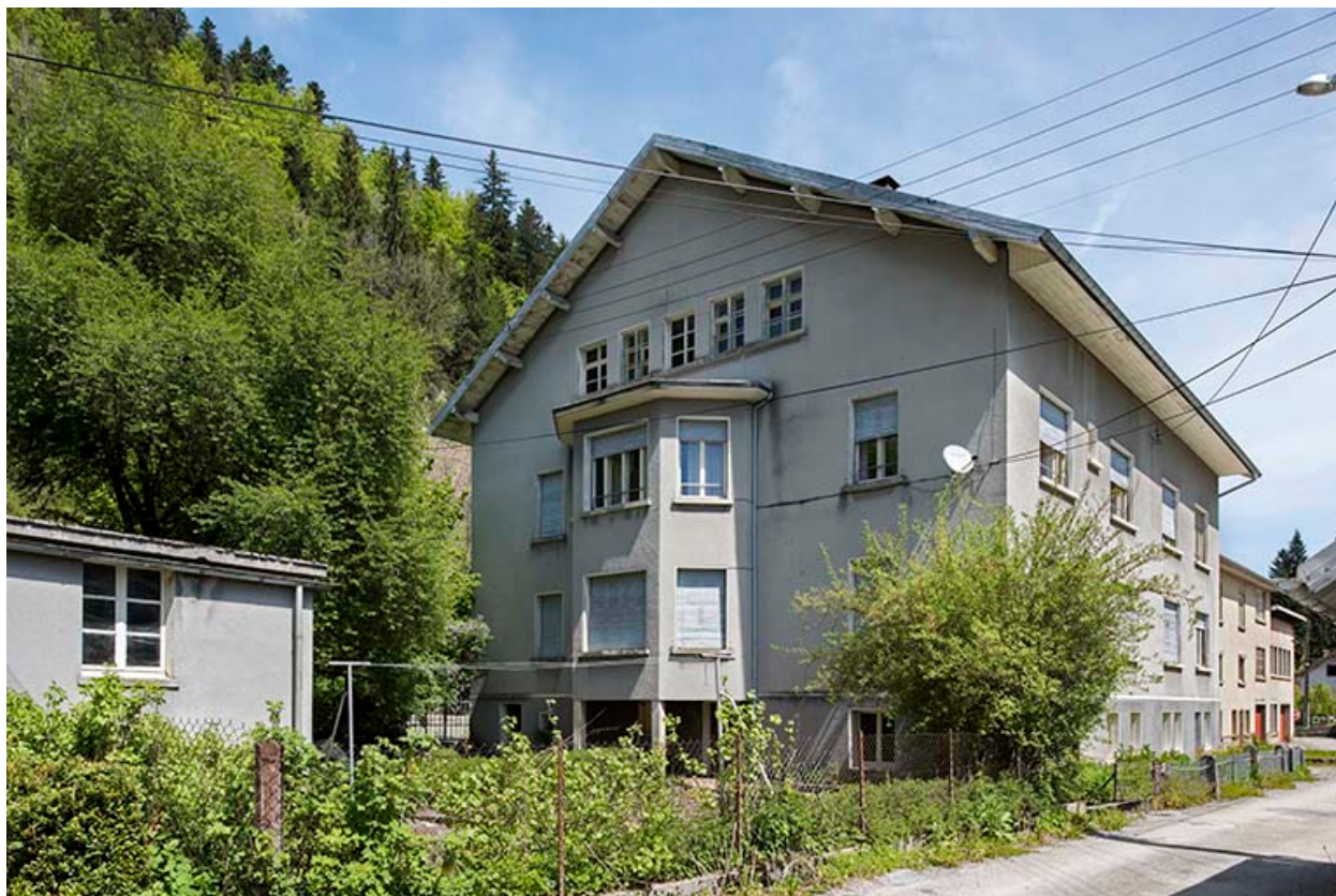
Façade latérale droite, de trois quarts droite.
