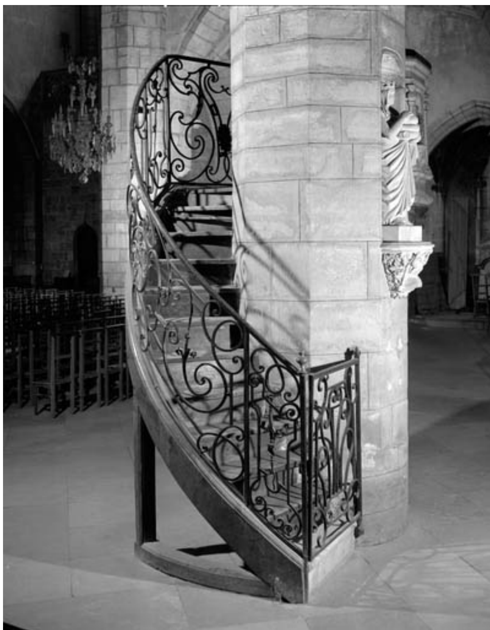
Vue d'ensemble de l'escalier en ferronnerie.
