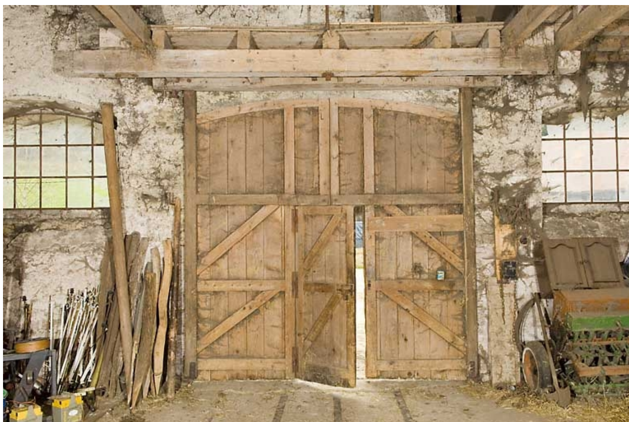
Grange haute : porte vue de l'intérieure.
