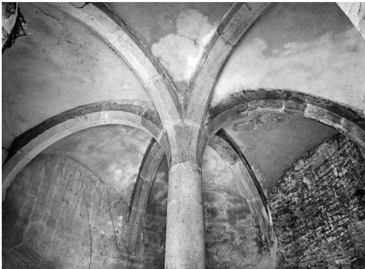
Tour Blondeau, casemate inférieure, détail : voûtement.
