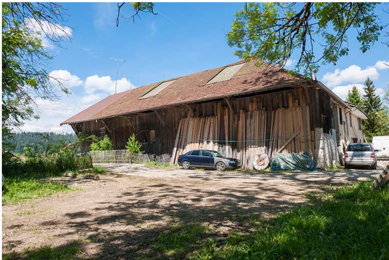
Atelier de scierie vu depuis le sud-est.
