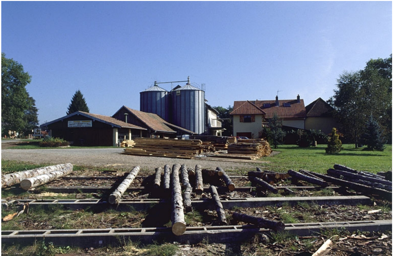
Scierie et minoterie depuis l'ouest.
